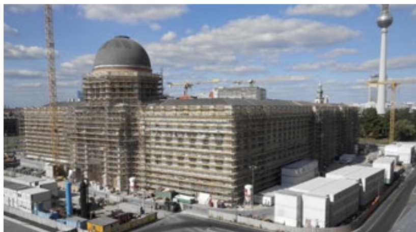
Abb. 1: Das neue Berliner Stadtschloss in der Bauphase 2018
