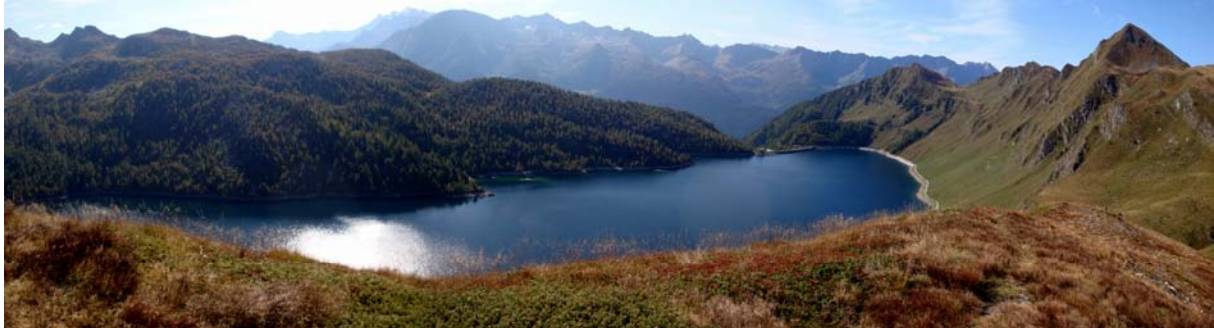
Lago Ritom im Val Piora: Hauptspeichersee, dessen Wasser durch Druckleitungen ins Tal schiesst Foto: © HADES (Originalbild ersetzt)
