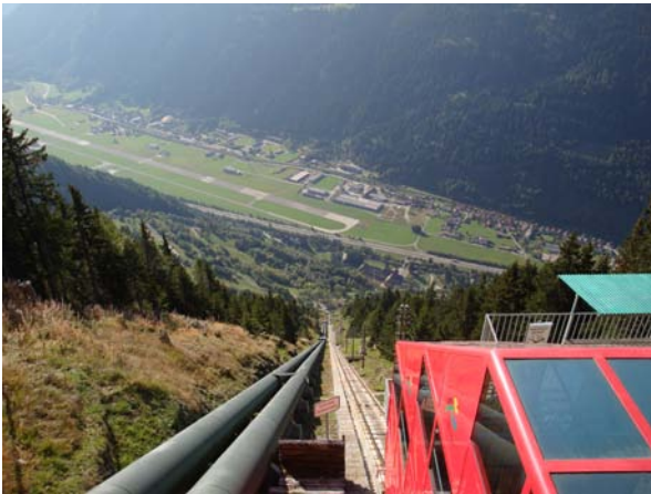
Druckleitung zum Ritom-Kraftwerk, Standseilbahn Foto: © HADES (Originalbild ersetzt)
