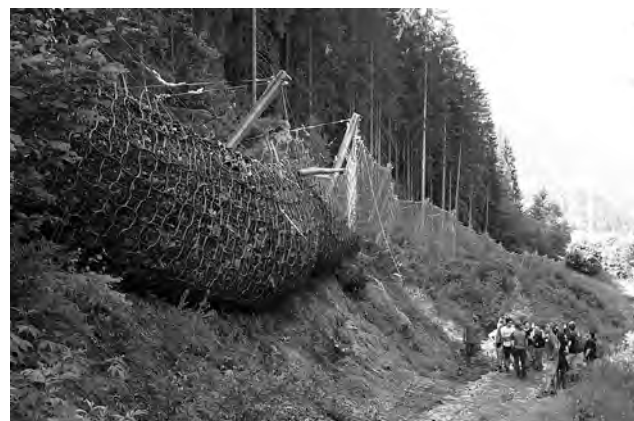
Abb. Tirol 1: Stahlseilsicherung im Paznauntal
