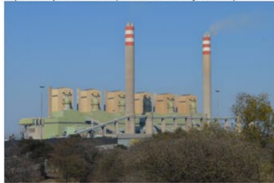
Matimba Kohlekraftwerk, Limpopo Provinz (Foto: Haferburg, 2016)
