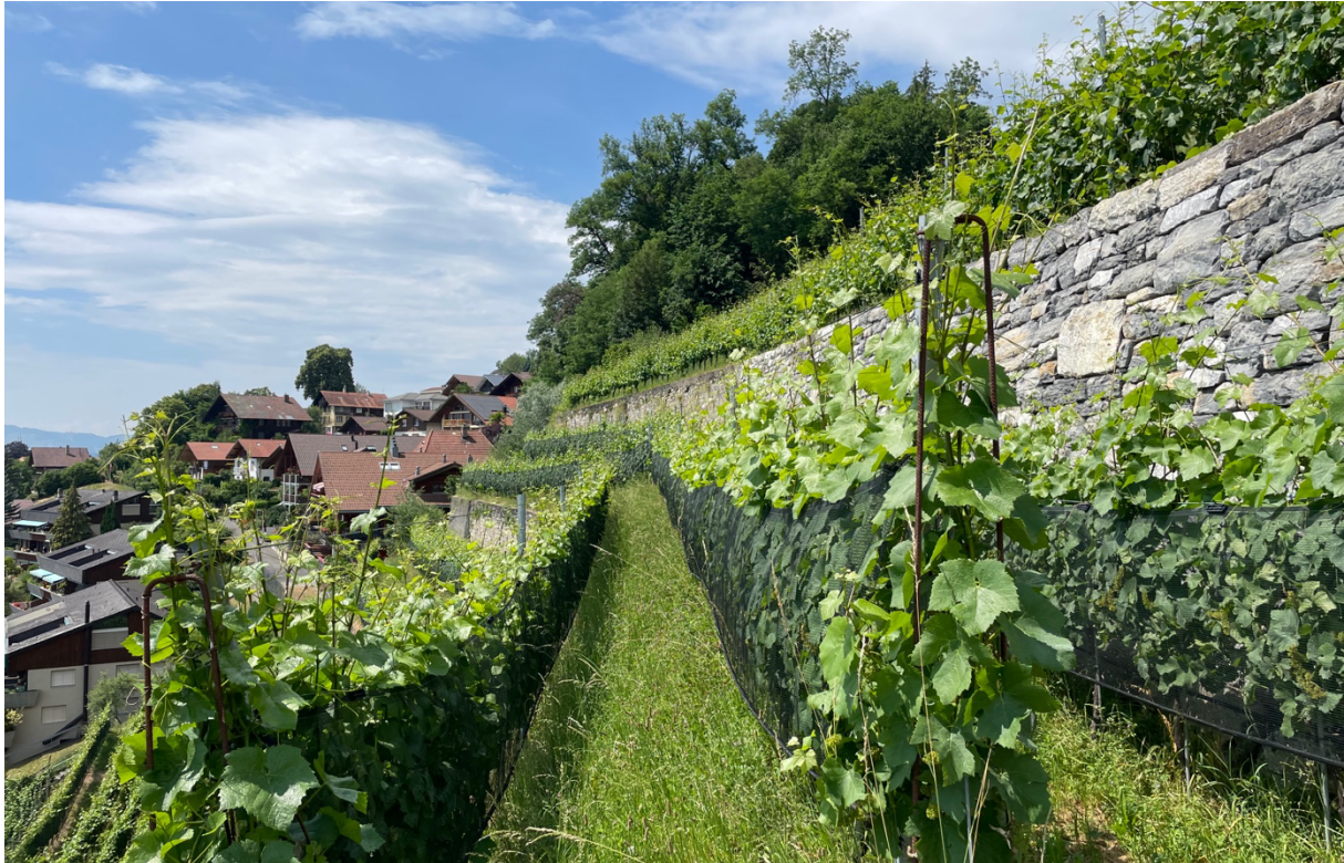
Abbildung 1: eine Trockensteinmauer in einem Rebberg in Oberhofen am Thunersee (BE), deren Erneuerung vom FLS unterstützt wurde (Foto: Mauro Schmid)
