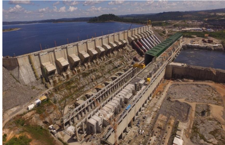
Wasserkraftwerk Belo Monte, Pará, Brasilien, o. J. (Foto: PAC [Programa de Aceleração do Crescimento] 2017 [flickr.com/photos/pacgov/36654588340])
