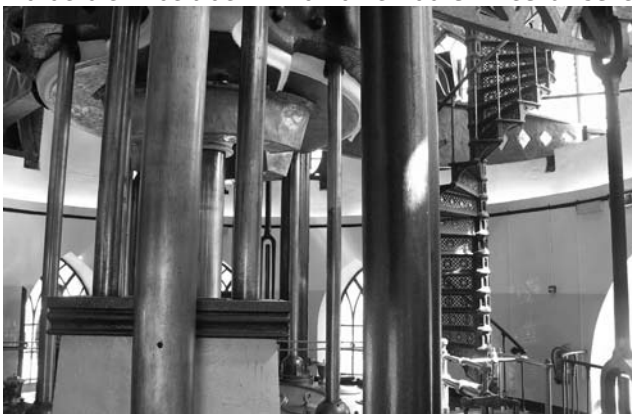
Abb. 7: Pumpwerk Cruquius (Bild P. Heitzmann)
