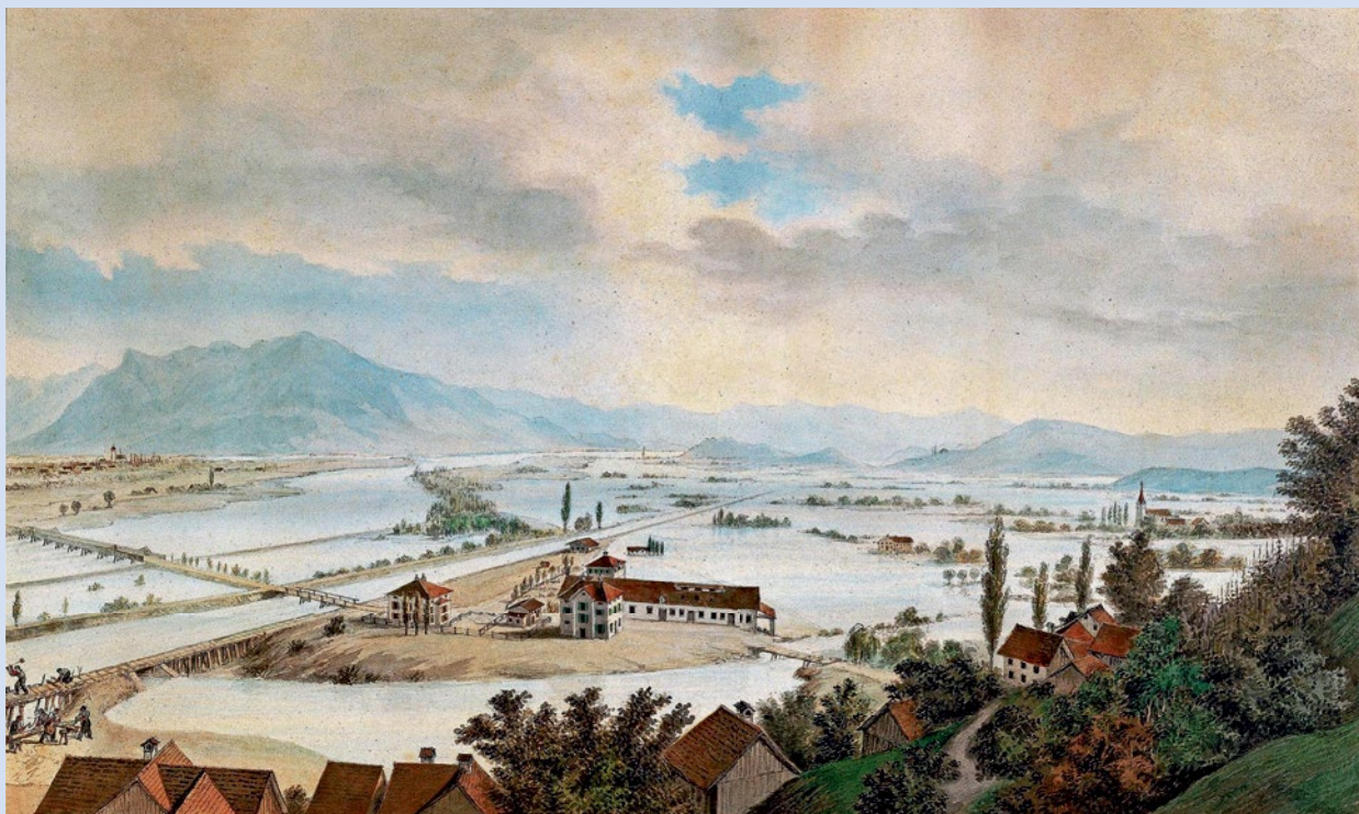
Fig. 28: Inondation de 1868 près d'Au (SG) 1 (aquarelle). On aperçoit tout à gauche le pont ferroviaire endommagé. Cette peinture, jugée très fiable et contemporaine de l'évènement, rend nettement mieux compte que n'importe quelle source écrite l'importance des inondations dans la vallée du Rhin, en particulier quand on la combine avec une prise de vue détaillée telle que l'ancienne photographie de Lustenau (fig. 1, Lustenau est à l'arrière-plan gauche de l'aquarelle). Cependant, on ne sait pas si l'image représente le niveau d'eau le plus haut ou plutôt – au vu des travaux de réparation déjà entamés – un niveau déjà en train de s'abaisser.
