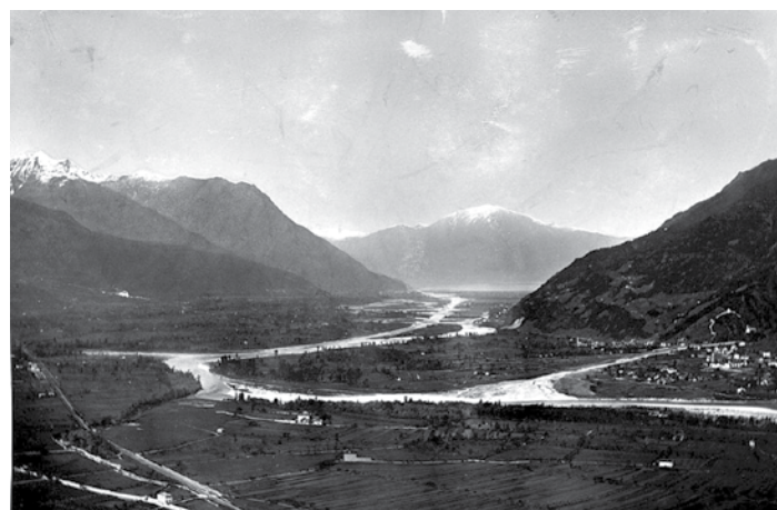
Fig. 51: Vista del fiume nei pressi di Giubiasco 1 e sul Piano di Magadino. Fotografia risalente agli anni 1880. I lavori di correzione erano già stati avviati, ma è ancora visibile il corso del fiume originale.
