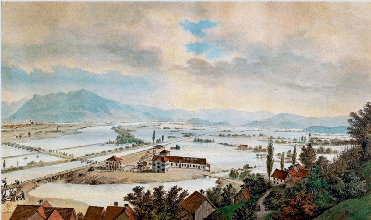
Abb. 28: Die Überschwemmung von 1868 bei Au (SG) 1 (Aquarell). Ganz links wird die beschädigte Bahnbrücke wiederhergestellt. Das als sehr zuverlässig und zeitgenössisch einzustufende Bild kann deutlich besser als jede schriftliche Quelle das Ausmass der Überschwemmungen im Rheintal veranschaulichen, insbesondere, wenn sie mit Detailaufnahmen, etwa der frühen Fotografie aus Lustenau (Abb. 1, auf dem Aquarell links im Hintergrund), kombiniert werden. Allerdings bleibt unklar, ob das Bild den Höchstwasserstand wiedergibt oder – aufgrund der schon einsetzenden Reparaturarbeiten – wohl eher einen bereits sinkenden Wasserstand.
