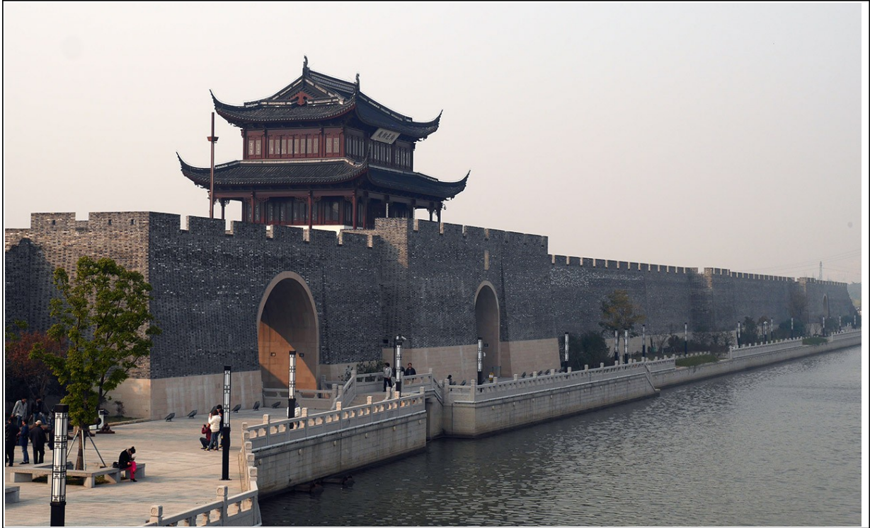
Wiederaufgebaute Stadtmauer Suzhou Foto: Breitung, 2013
