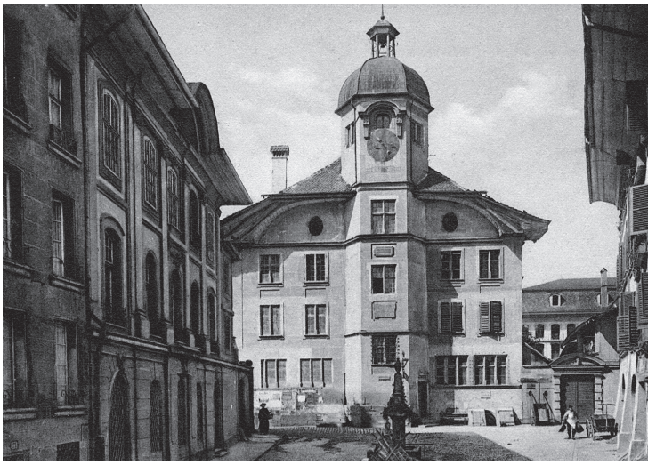
Die ersten Berner Geographie-Professoren lehrten noch im Gebäude der «Hohen Schule» an der Herrengasse 7.
