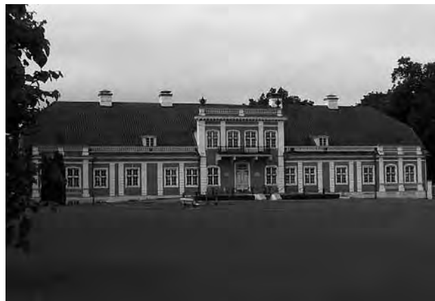
Abb. 3: Das Herrenhaus des Gutshofes Sagadi wurde im Jahre 1750 erbaut und 1793 frühklassizistisch erneuert, zum Gutshof gehört heute ein Hotel und ein Forstmuseum.
