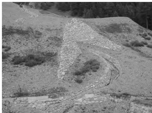
Abb. 4: Schutzverbauungen oberhalb Pontresina
